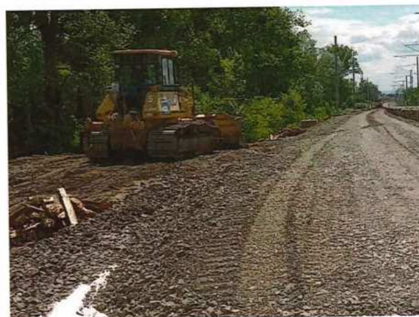
UČS 12, Rozprestretie geotextílie a zriadenie pláne železničného spodku
