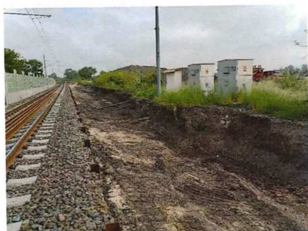
UČS 11, Odkop zeminy a výmena škvarového podložia
