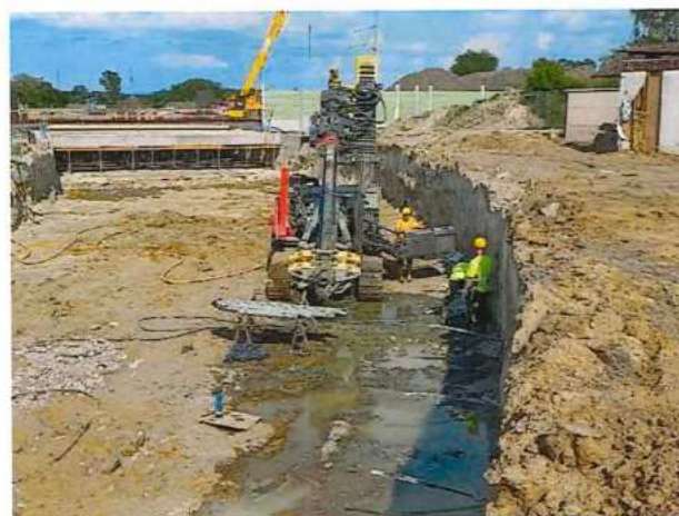
UČS 11, Kotvenie stien podjazd
