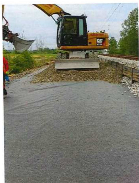
UČS 12, Rozprestretie geotextílie a zriadenie pláne železničného spodku
