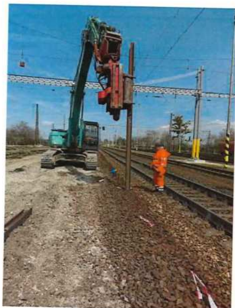
UČS 02, Baranenie HEB, záporové paženie a odťazenie kameniva pod koľajou č. 1
