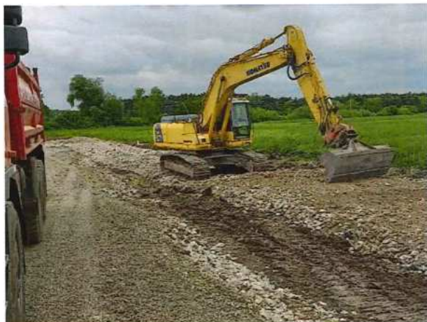
UČS 11, Budovanie prístupovej komunikácie a rampy podjazd
