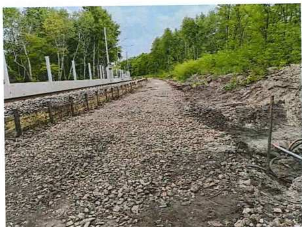
UČS 11, 10, Odčazenie koľajového kameniva a zemín po zemnú pláň
