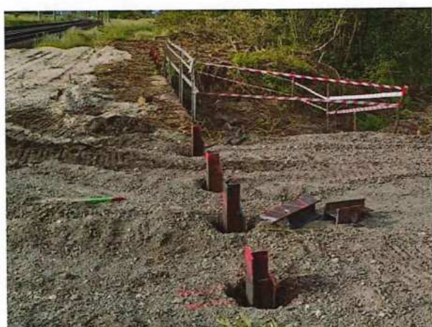
UČS 0,1 Baranenie kontrastných HEB profilov pri priepustoch a mostoch
